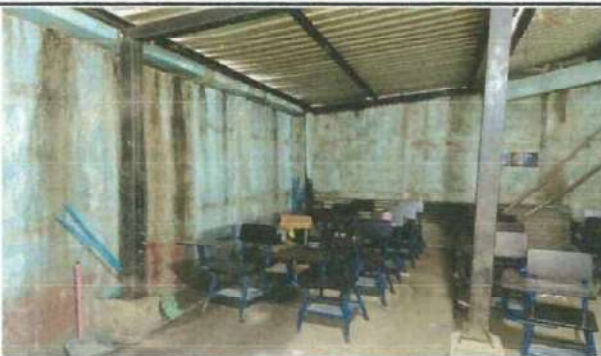
Foto 6: Las paredes de un aula en mal estado por filtración de agua de lluvia y que requieren mantenimiento con aplicación de repello.
