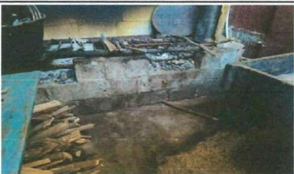
Foto 5: En el área de cocina necesita mejora con la sustitución de estufa rural que incluye plancha de metal.
